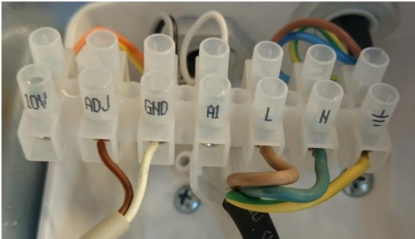
Östberg Tkc/Tks 400 EC: Brun till ADJ (gul). Vit till GND (svart & grå)
